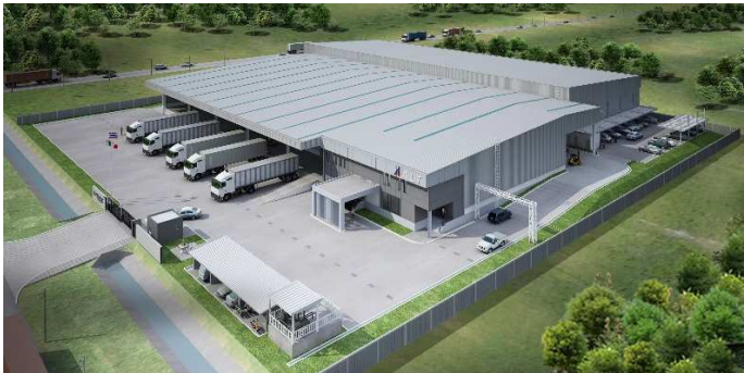
建物外観 ※写真奥が第二倉庫
